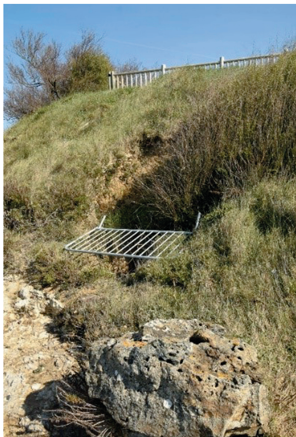
Figure 14. Effondrements liés au débouffage des conduits karstiques et au soutirage des matériaux de couverture (Saint-Georges-de-Didonne - Cerema).
